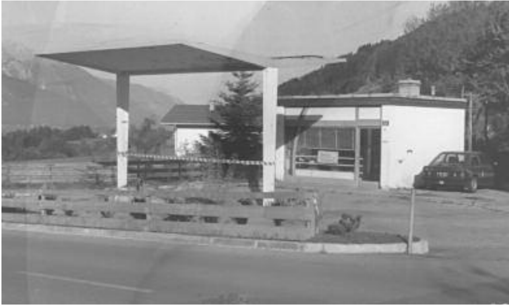
Im November 1989 sind die Zapfsäulen der Tankstelle bereits abgebaut
