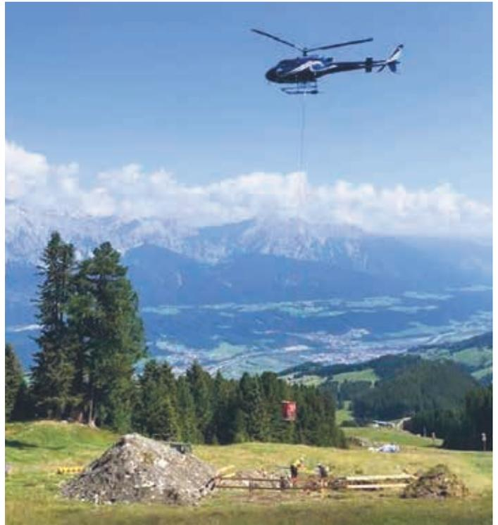
*Die meisten Stützenfundamente mussten per Hubschrauber betoniert werden*
