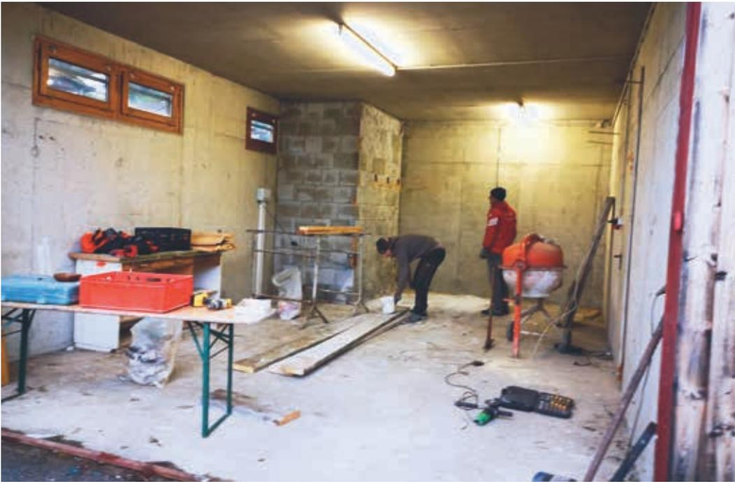
Das alte Garagentor wurde durch eine massive Mauer ersetzt (siehe auch Bild rechts)
