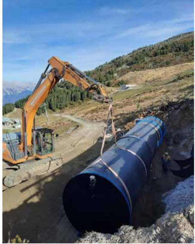
Die Steinschichtung vor dem Behälter und finale Einschüttung, elektrische Anschlüsse und Zulauf, werden wir im Frühjahr 2023 erledigen. Nach Fertigstellung der neuen Wasserstube wird der alte Hochbehälter zur Gänze abgetragen und entsorgt werden. Das Investitionsvolumen beläuft sich auf rund € 200.000,-, davon werden wir aber eine beachtenswerte Summe gefördert bekommen.
